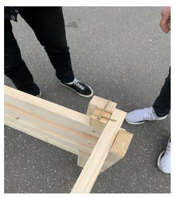
Die erste Überlegung war ein Stück Holz in den inneren Ecken zu befestigen und dieses mit zwei Schrauben zu sichern. Da wir dann aber gemerkt haben, dass dieses Holz splittert, wenn man Schrauben, so wie wir wollten, benutzt, konnten wir diese Lösung nicht mehr nutzen. Dann haben wir erst mal weiter überlegt, wie wir die Seitenteile befestigen können. Zudem kam, dass wir eine Lösung brauchten, die nachhaltig ist und einfach wieder abzubauen ist.
