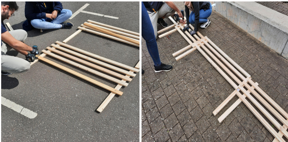
Abbildung 2 Festschrauben der Kanthölzer
