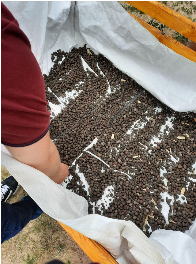
Abbildung 8 Blähton Befüllung
