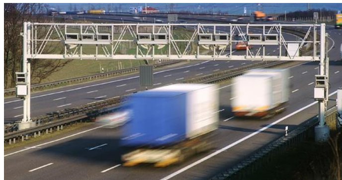
Abbildung 2: Eine Kontrollbrücke der Toll Collect GmbH auf der Bundesautobahn 3
